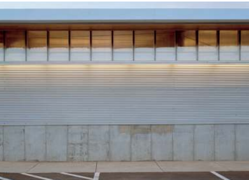
Binanın güney cephesinden de bina içine ışık giriyor.
