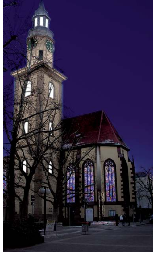
İşaret noktası olarak Büchsenstrasse'de bulunan kilise. İç ve cephe aydınlatmasının gösterilmesi. Ön planda Stuttgart'ın eski küre biçimli lambaları görülüyor. Uygulama: licht | raum | stadt-planung
