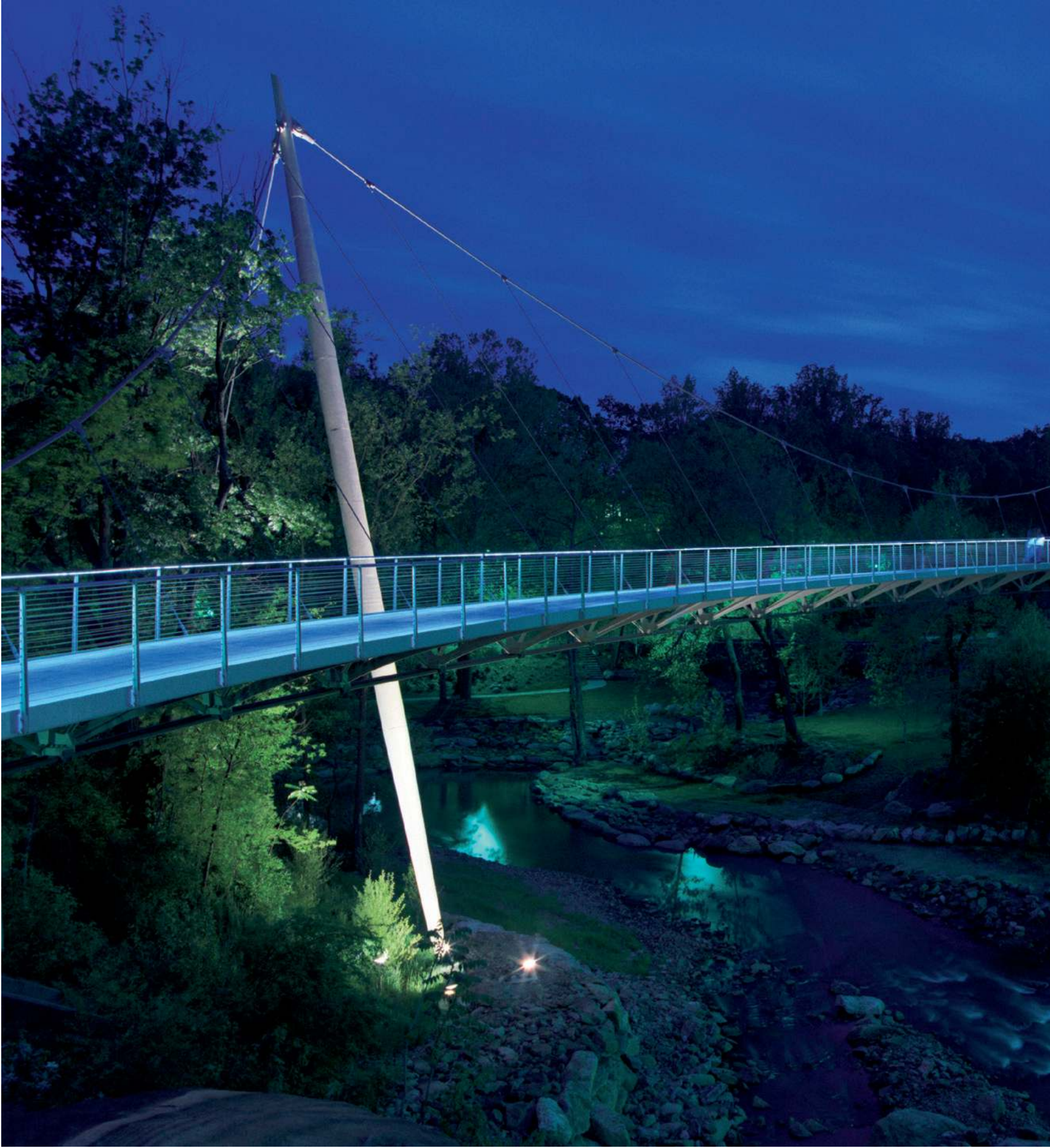
Liberty Köprüsü sık bir biçimde nehir ve uçurumun üzerinden geçiyor. Köprünün ağırlığı ayaklardan verilen çelik bir konstrüksiyon ile taşıyor. Aydınlatma tasarımı, doğanın görüntüsüne uyum sağlayacak şekilde yapılmış.
