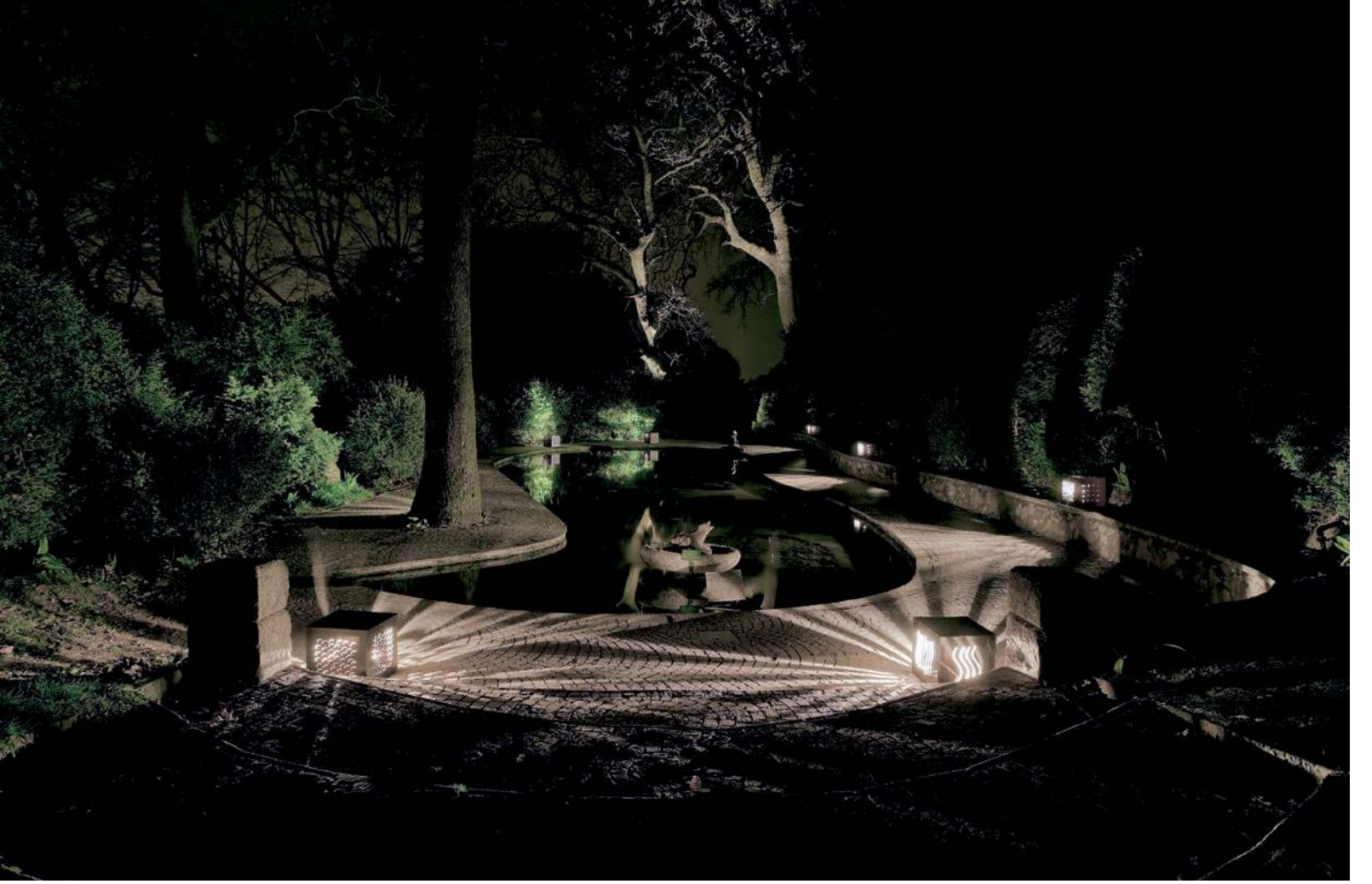
Isığın yansıtıldığı alanda her sablon özel bir desen yaratıyor. Sistem kalıcı bir uygulama olarak düşünülmüş ve vandalizme karşı emniyet tedbirleri alınmış.
