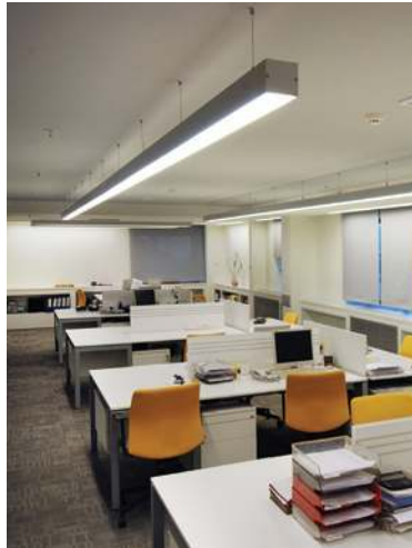
Ofislerdeki lineer aydınlatmalar
