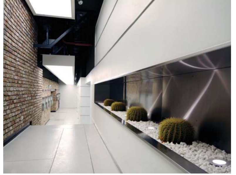
Giriş bölümü; ışıklı gergi tavan, halojen duvara gömme ve parapet üzerine gömme armatürler.
