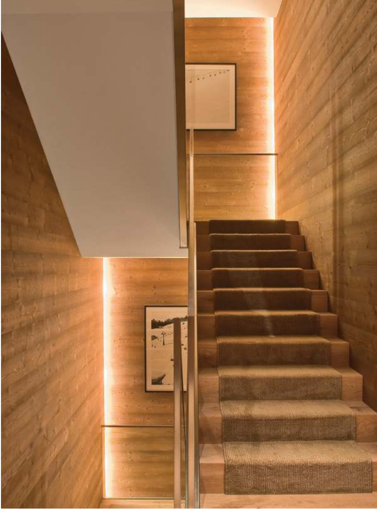
Üstteki fotoğraf: Merdiven sahanlıkları flüoresanlar ile endirekt aydınlatılıyor.
