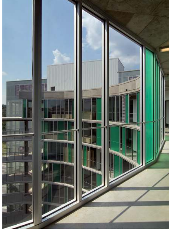
Binanın dış cephesi cam kaplı. Cama uygulanan folyo hem dışarıdan estetik desenlerin oluşmasını hem de iç alandaki koridorların günışığı ile aydınlanmasını sağlıyor.
