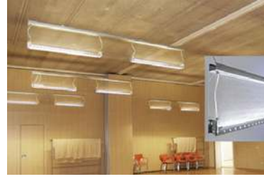
Sekil5: Çınlama süresini azaltan aynı zamanda genel aydınlatma sağlayan sarkıt elemanlar [4].
