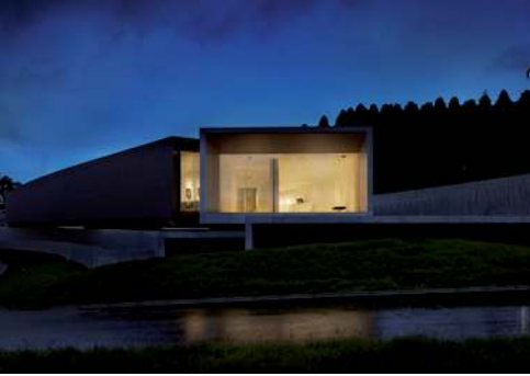
Müze binası, Chiba kentinin en büyük parkı olan Showa-no-Mori-Parkı yanında yer alıyor ve bir yer üstü ve iki yer altı kattan oluşuyor. Galeriler koridorlar şeklinde tasarlanmış ve 500 m sergi alanı sunuyor.
