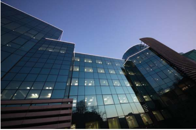
Kontur aydınlatma - yapının cam cepheleri asimetrik ve keskin köselere sahip, çizgisel aydınlatma gökyüzü ile yapı arasındaki sınırı temsil ediyor.
