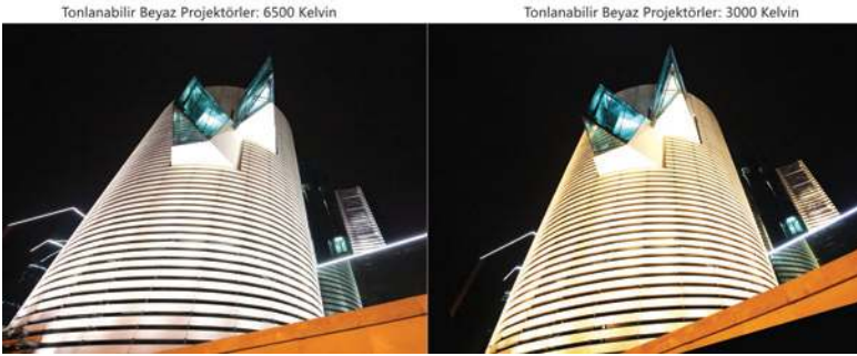
48 adet tonlanabilir beyaz LED projektör, 3000 Kelvin ile 6500 Kelvin arasında renk sıcaklığı değişimi sağlayabiliyor ve belli bir senaryoya göre çalışıyor.
