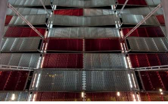
Sol: Dış kılıfın LED'li ısıtıcı rayları ile içeriden görüntüsü
