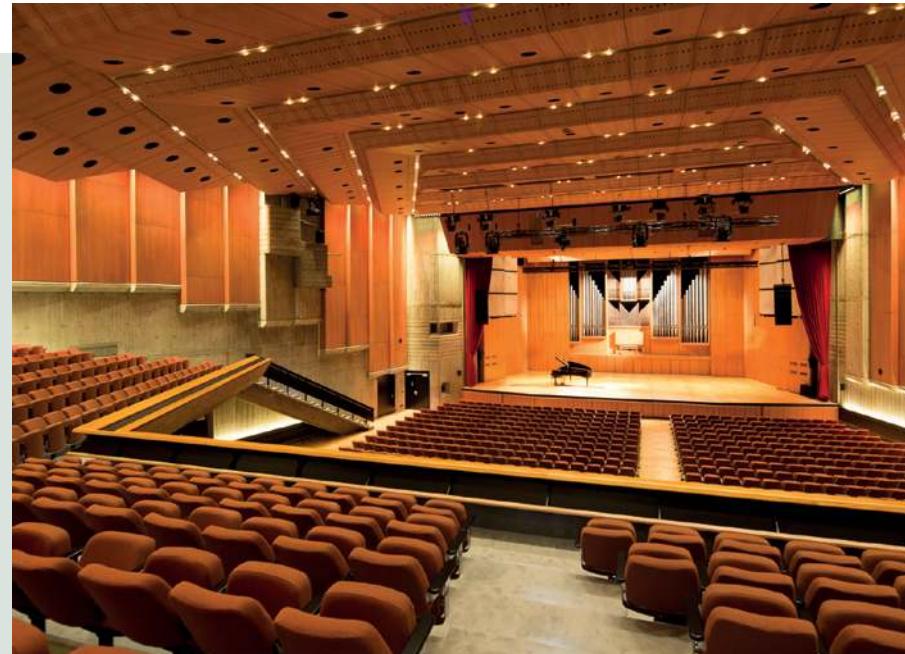
Konser ısıığı ile donatılmış konser/konferans salonu. Yatay aydınlatma: LED'lerle saęlanıyor. 3'lü Projektör grupları 3000K'lık beyaz ısıık ile donatılmış; 12 m yükseklięindeki mekânın tavan kanallarından 2.000 Lumen; 28 ısıık yansıyor. Dikey aydınlatma: Tavanın gölge aralıęından Power LED profilleri yansıyor ve kademeli beton kenarını öne çıkarıyor. Trabzanlara entegre edilen LED Flexprofil, beton duvarı aydınlatıyor.
