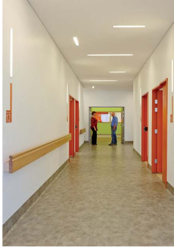
Hasta odaları kapılarının yanındaki koridorlara ve geçişlere yön tayini için düz, dikey konumlu lambalar monte edilmiş.
