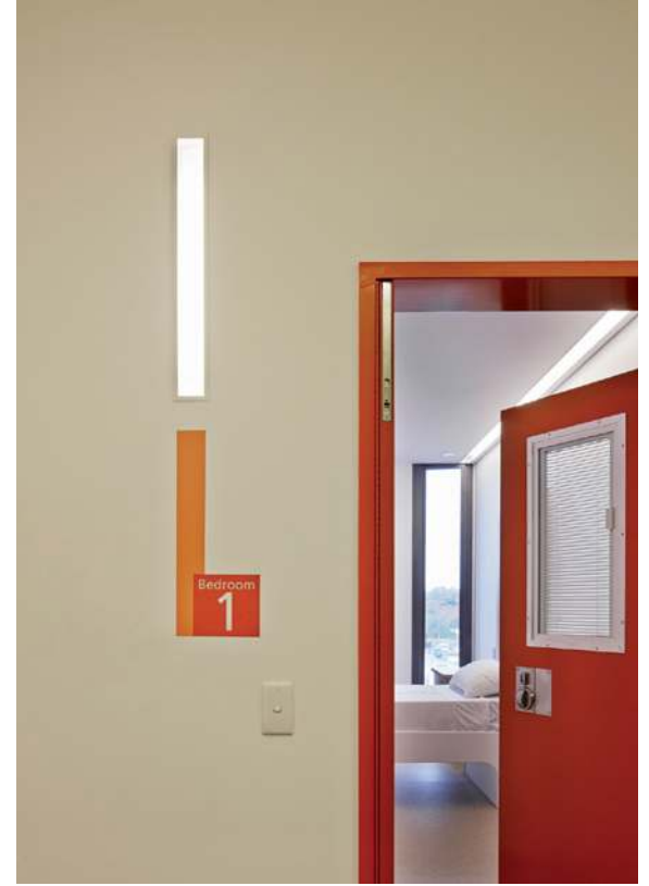
Hasta odaları kapılarının yanındaki koridorlara ve geçişlere yön tayini için düz, dikey konumlu lambalar monte edilmiş.
