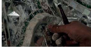
Ayna parçacıkları duvara uygulanır.
