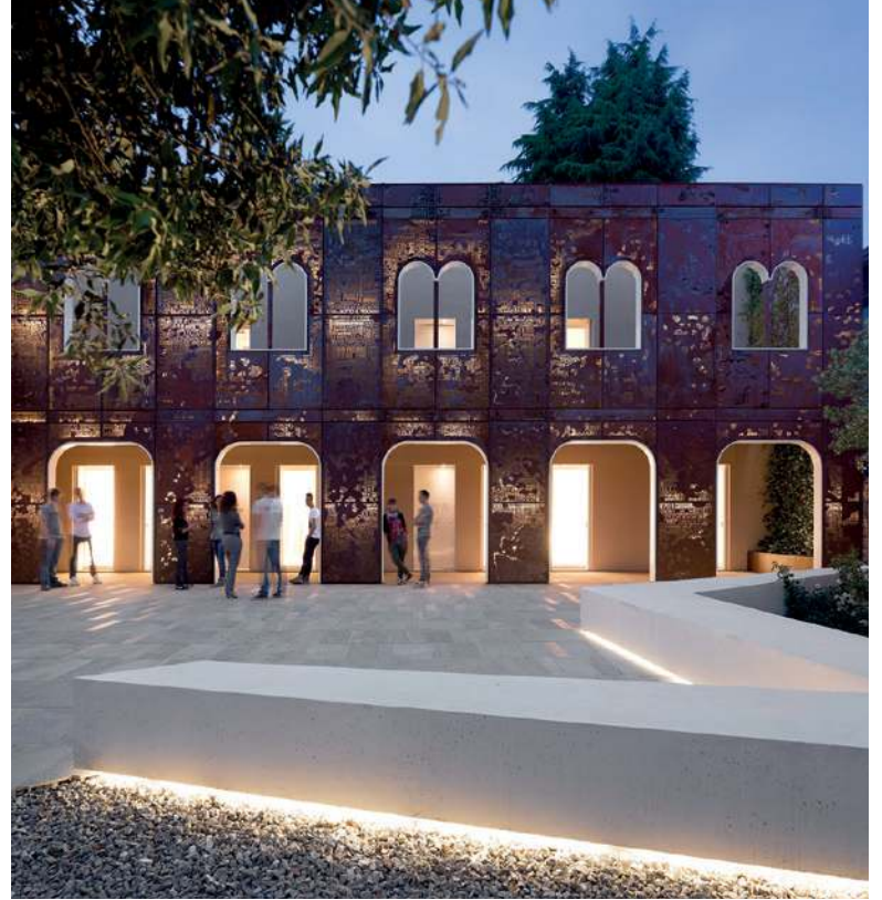
Bina cephelerinin geniş alanlı aydınlatması için esnek LED şeritleri uygulanmış. Aynı sistem binanın avlusunda, oturma birimlerinin altına yerleştirilmiş. LED şeritler özenle zemine uygulanmış, böylece kamaşma oluşmuyor.
