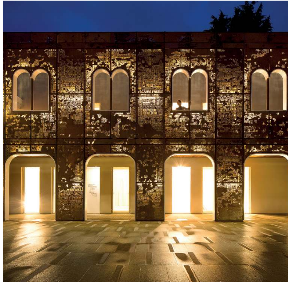
Kemerlerin arasındaki sütunlara entegre edilen duvara monte LEDler mimariyi göze batmayacak şekilde vurguluyor.
