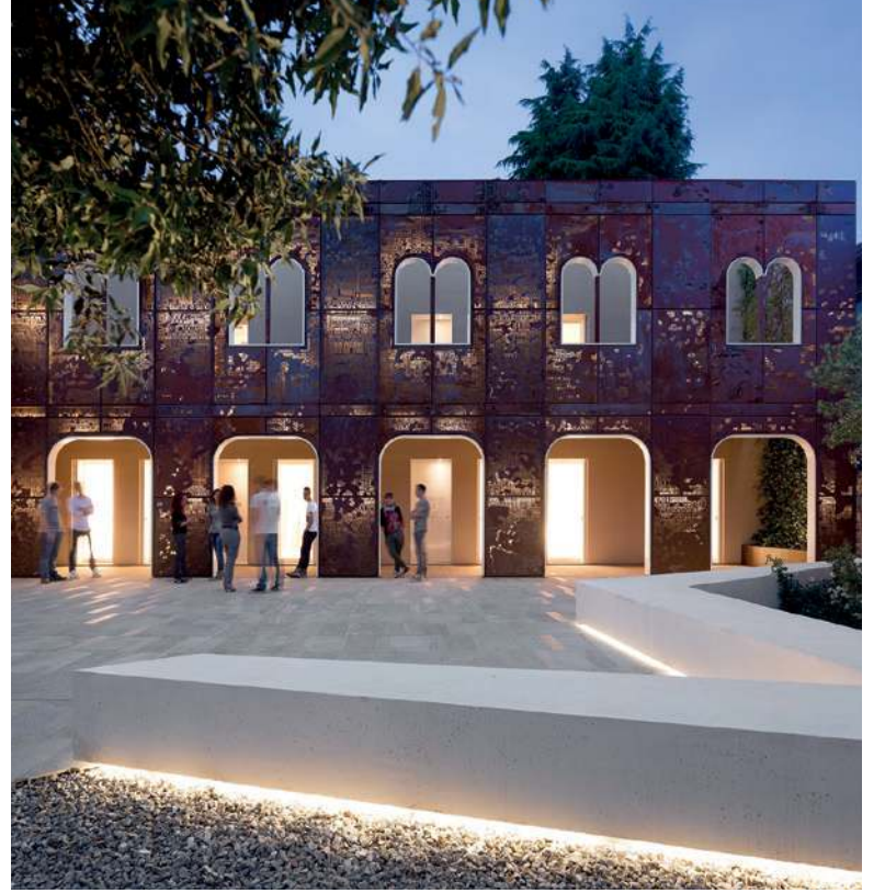
Bina cephelerinin geniş alanlı aydınlatması için esnek LED seritleri kullanıldı. Aynı sistem binanın avlusunda bankların altına yerleştirildi. LED seritleri zemine gömülü yerleştirildikleri için ısı kamaşmasına neden olmuyor.
