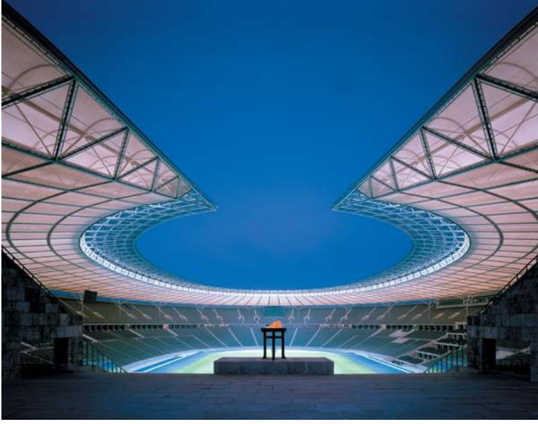
Berlin'deki Olimpia stadyumunun ana tribününün üzerine yeni bir membran çatı kaplanmıştır. Işık nedeniyle gündüz ve geceleri stadyum çatısının havalanmış olduğu hissi uyanıyor. Aydınlatma tasarımı: Helmut Angerer, Conceptlicht
