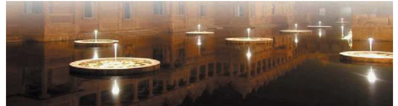
Ana binanın etrafındaki göletlerde birçok lotüs adacıkları oluşturulmuş, bunlar mantar şekilli Poller (CDM-T, 35 Watt) ile aydınlatılıyor.
